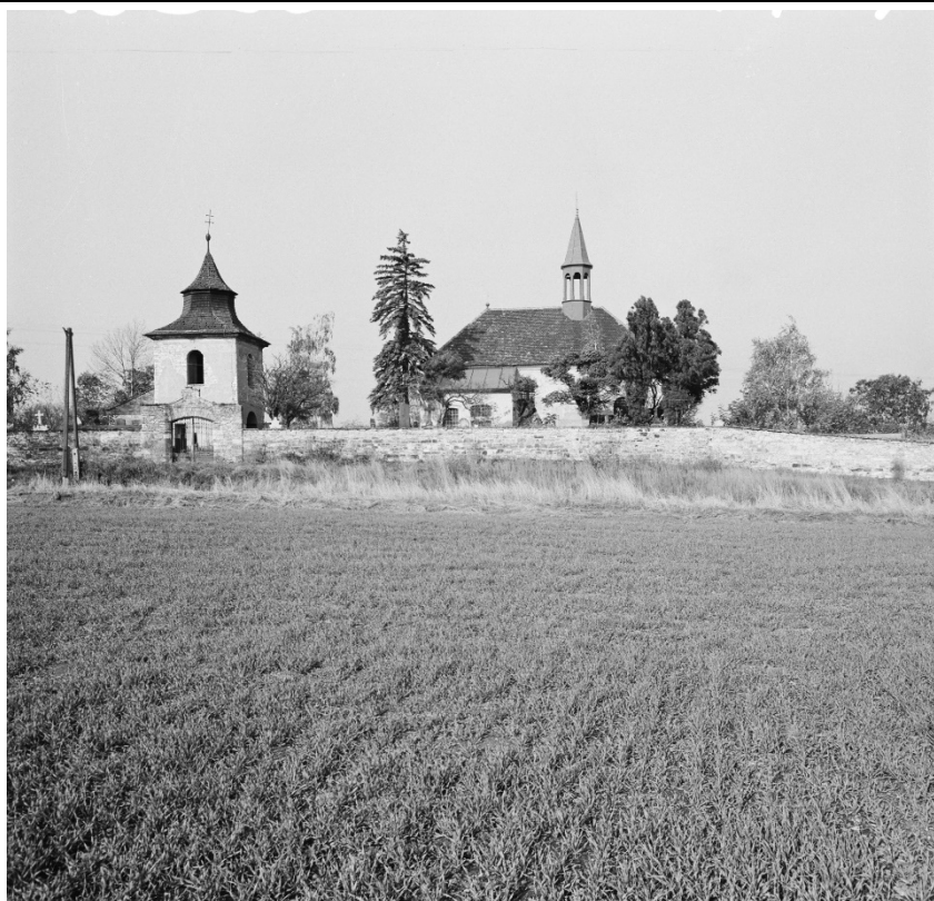
Celkový pohled od jihu. Foto: 1987, sbírka negativů NPÚ ÚOP v Ústí n. L., sig. 96230.
