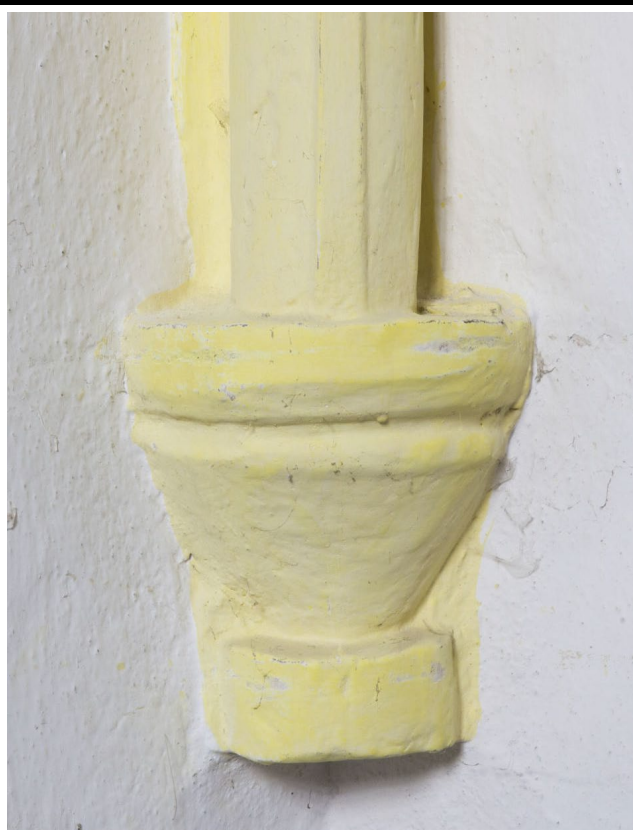
Detail severozápadní konzole presbytáře. Foto: Marta Pavlíková 2020.
