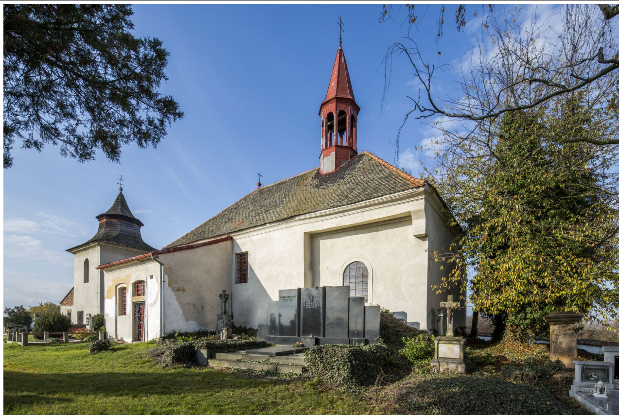
Celkový pohled od jihovýchodu. Foto: Marta Pavlíková 2020.
