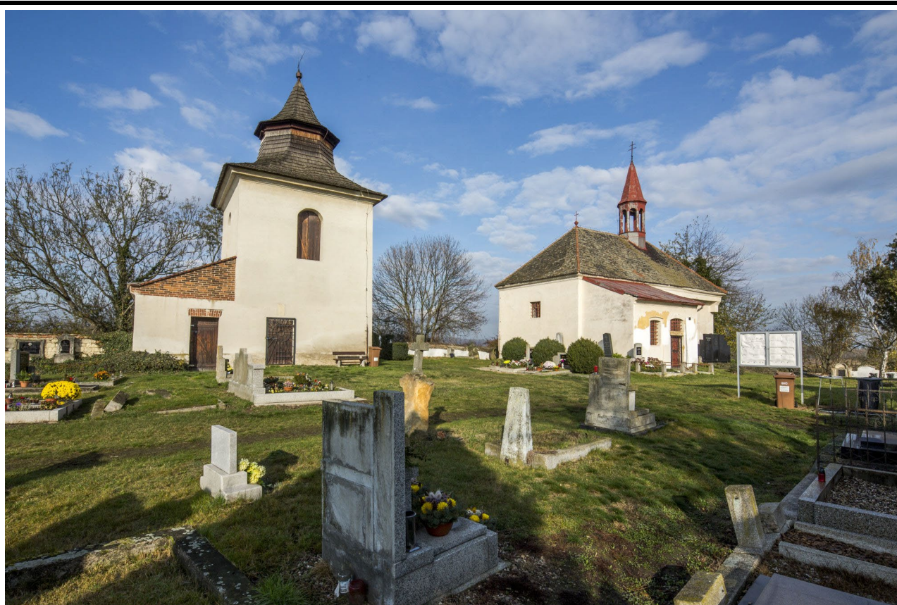
Celkový pohled od jihozápadu na kostel se zvonící. Foto: Marta Pavlíková 2020.
