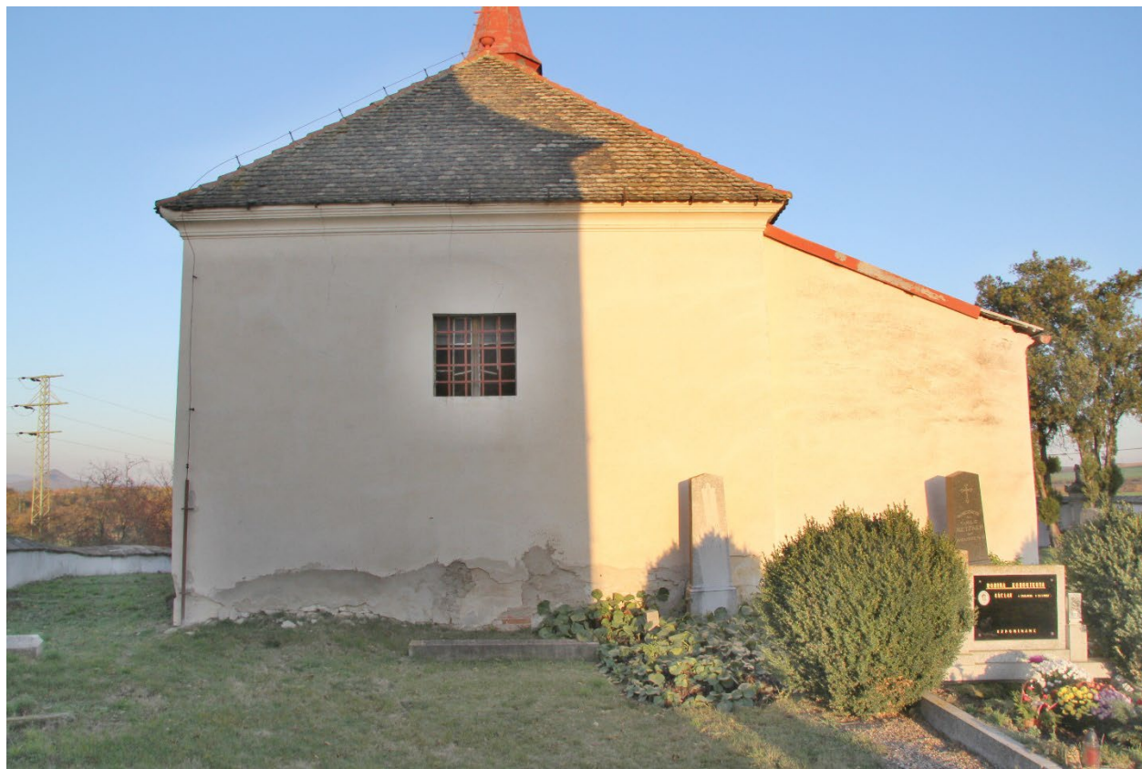
Západní průčelí kostela v pohledu od západu. Vlevo dole a vpravo dole patrné kvádry nárožního armování. Foto: Jaroslav Skopec 2020.
